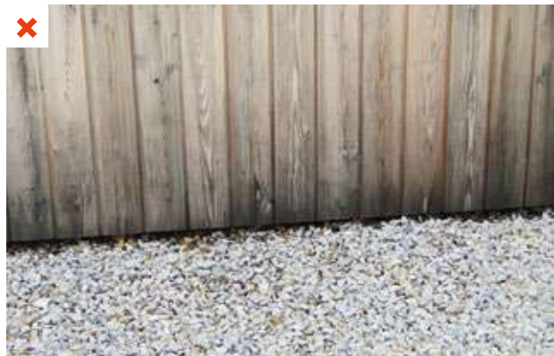
Le problème ici n'est pas normatif comme ci-dessus car le sol est drainant (gravier), cependant le bardage est tout de même trop près du sol empêchant une ventilation suffisante de la lame d'air (entraînant un noircissement). ©AQC
