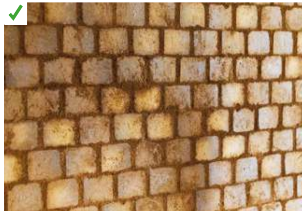
Augmentation de l'inertie thermique du bâtiment avec la mise en place d'une paroi intérieure en terre crue. ©AQC
