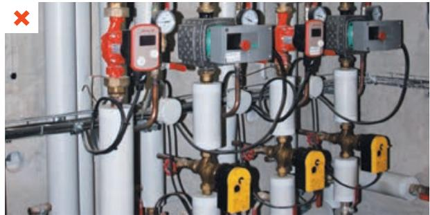
Panoplie d'un bâtiment passif : vannes et circulateurs non isolés. ©AQCC
