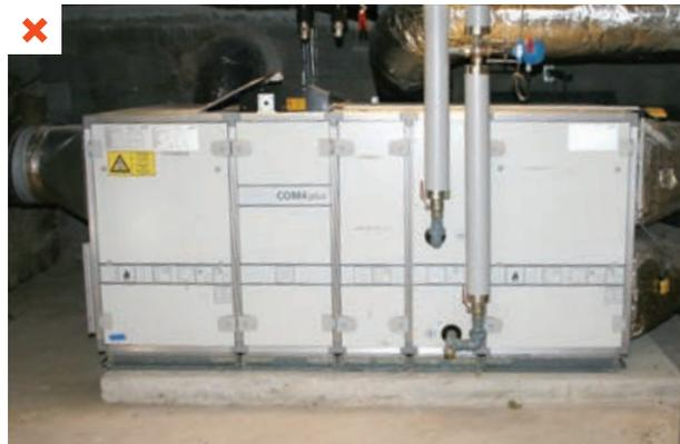
Les CTA sont plus réactives que les systèmes de chauffage à forte inertie. Elles montent vite en température et prennent le pas sur le système de chauffage principal. ©AQC
