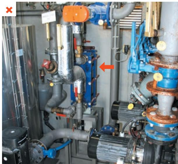
Chaufferie encombrée, accès à l'échangeur à plaque difficile. ©AQC
