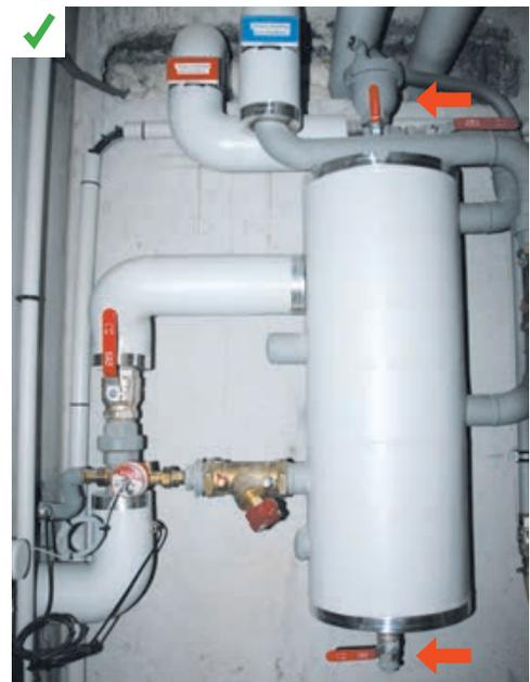
Bouteille casse pression avec purge en partie basse et dégazeur en partie haute. ©AQC
