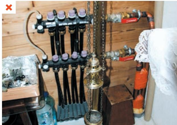
Réseau primaire en cuivre et réseau secondaire du plancher chauffant en PER (situation à risque si le PER est sans barrière anti oxygène). ©AQC
