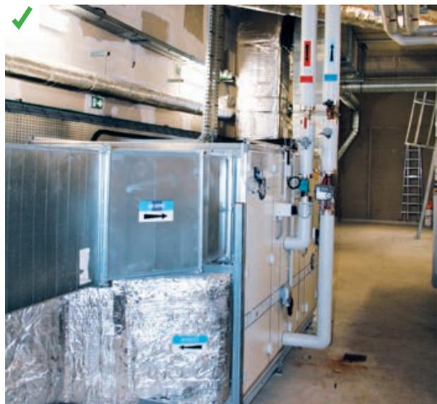
Régulation terminale par vannes deux voies associées à une pompe à débit variable permettant de réduire le débit dans la CTA. Ceci permet également de diminuer la consommation électrique des auxiliaires qui sont moins sollicités. ©AQC
