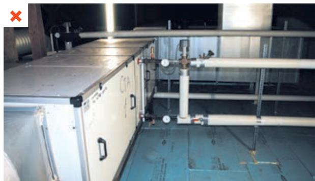
Régulation terminale par vanne trois voies au niveau de la CTA. Tout le circuit en amont est à haute température. ©AQC
