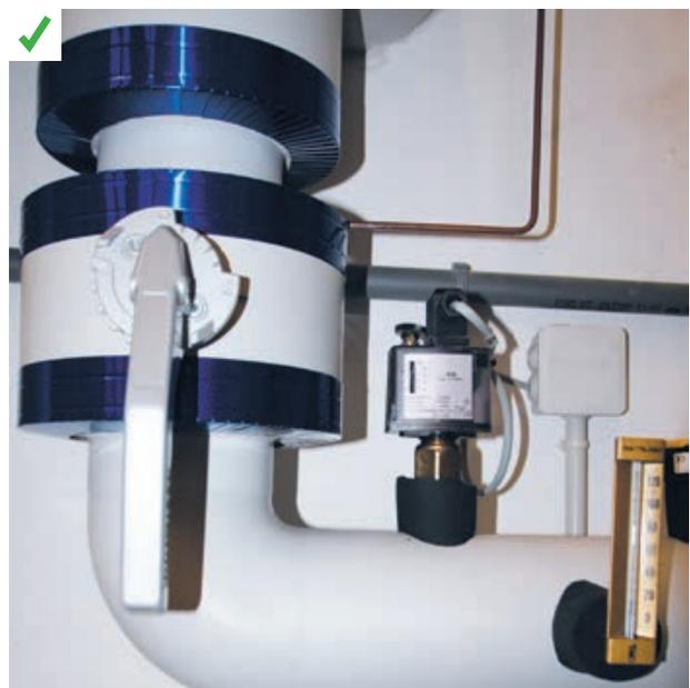
Bonne isolation : corps de vanne isolé et manchons isolants au pied des sondes et thermomètres. ©AQCC
