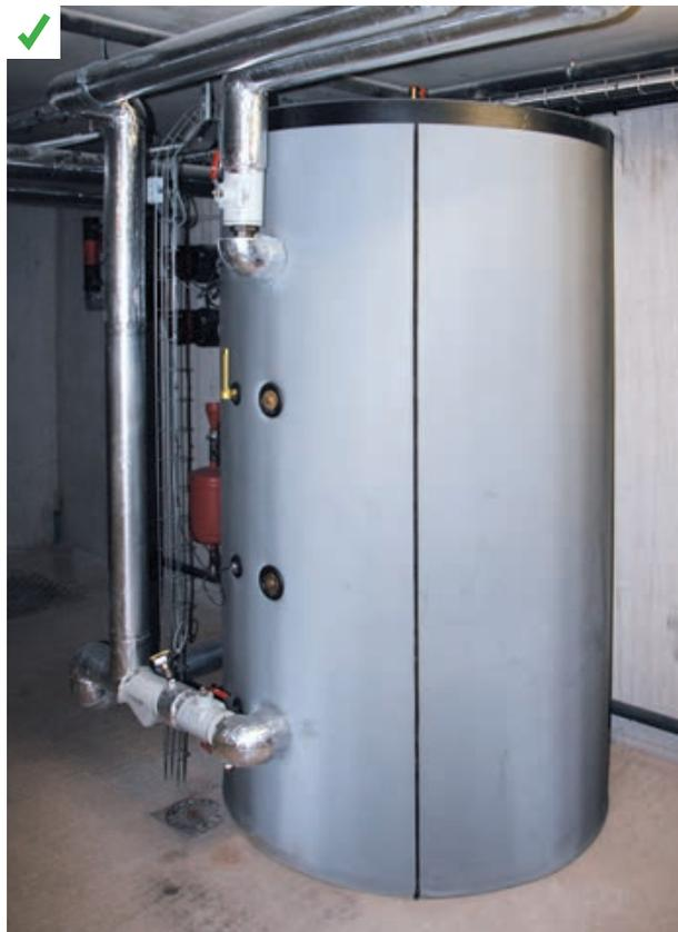
Ballon tampon 3 000 L servant de réservoir de chaleur pour le chauffage et l'eau chaude sanitaire de 18 logements passifs. La chaudière à pellets qui l'alimente à une puissance de 32 kW. ©AQC
