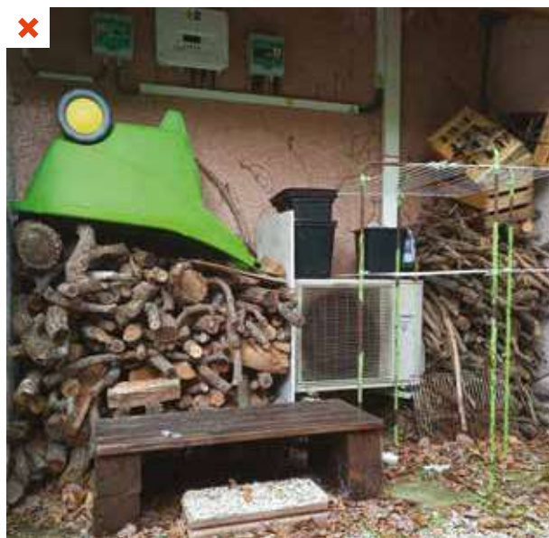
Les propriétaires stockent leur bois sous l'appentis prévu pour les équipements techniques. Les onduleurs sont difficilement accessibles. ©AQC
