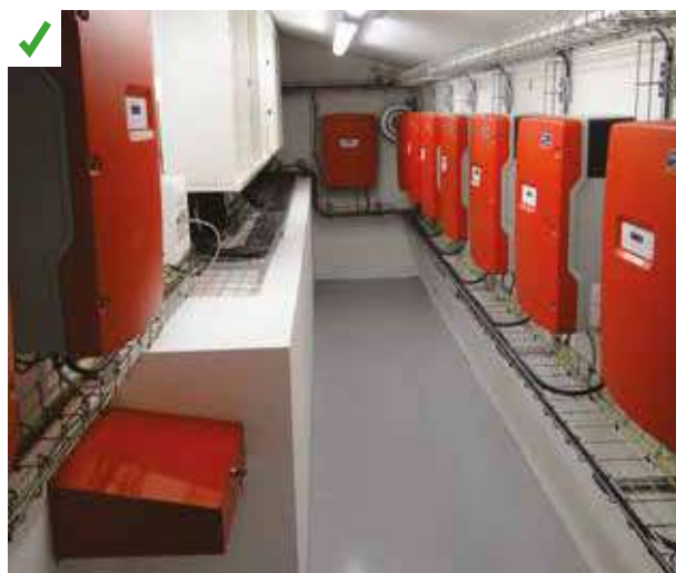
Local dimensionné pour assurer un accès aisé à chaque onduleur. ©AQC
