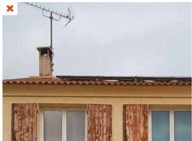
La cheminée projette son ombre sur les panneaux photovoltaïques durant plusieurs heures de la journée. Cet impact n'a pas été pris en compte et aucune disposition particulière n'a été prise. ©AQC
