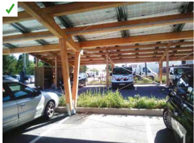
Les panneaux photovoltaïques sont utilisés comme ombrière pour les voitures stationnées. ©AQC
