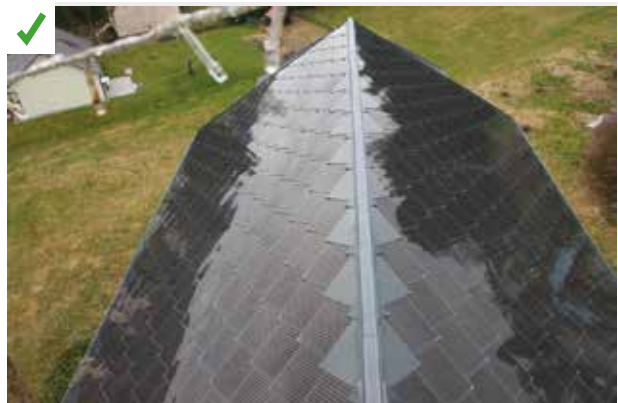
Réfection du toit d'une église avec intégration de tuiles photovoltaïques. La solution d'insertion a été validée par les services publics. ©AQC
