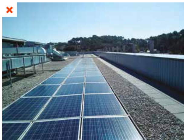
Par manque de place, les panneaux photovoltaïques sont installés à plat. Le rendement est diminué. ©AQC
