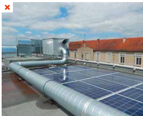
Par manque de place disponible, les panneaux sont positionnés entre l'acrotère et une gaine de ventilation. Ils reçoivent les ombres portées de la gaine sur certaines périodes de la journée. ©AQC
