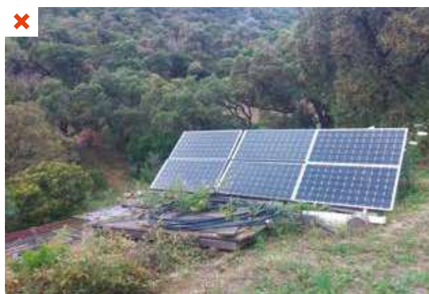
Pour les installations au sol ou sur une toiture végétalisée, la coupe des végétaux doit être régulièrement réalisée autour des modules pour ne pas projeter d'ombre qui diminuerait le rendement. En cas d'incendie, cet entretien permet de limiter la propagation du feu. ©AQC
