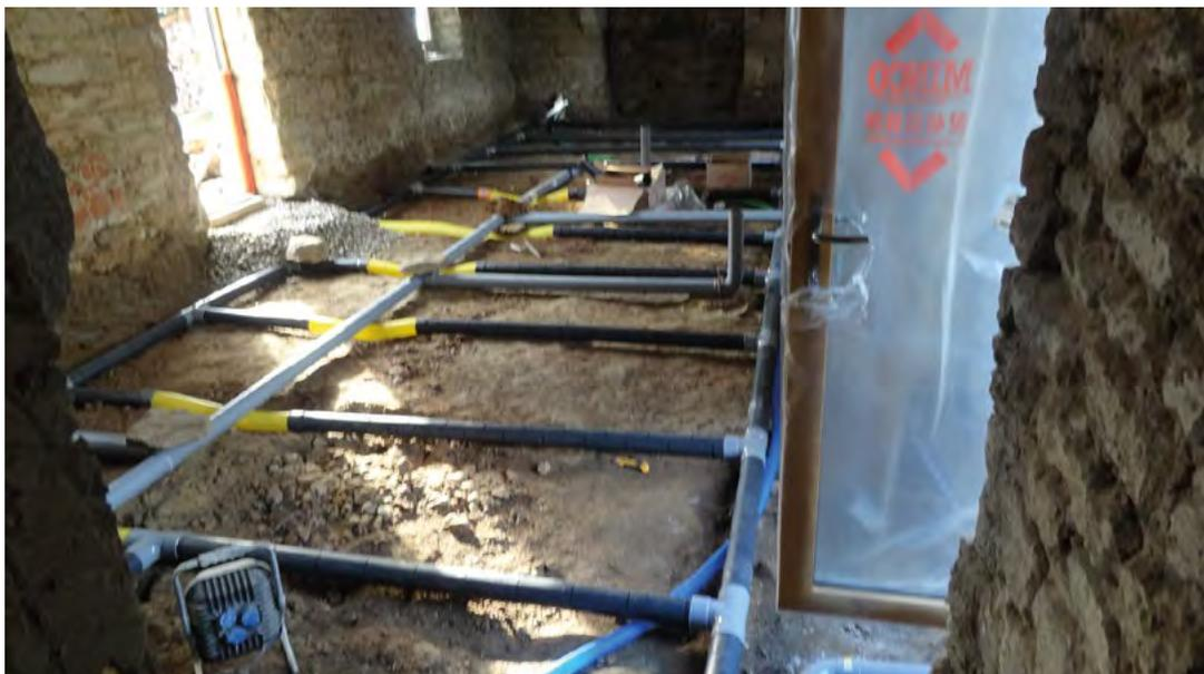
**Figure 6 - Installation d'un hérisson ventilé en rénovation © Brélivet**
