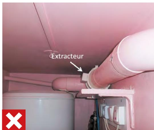
*L'extracteur aurait dû être positionné à l'extérieur des locaux ou dans les combles ©AQC2015*
