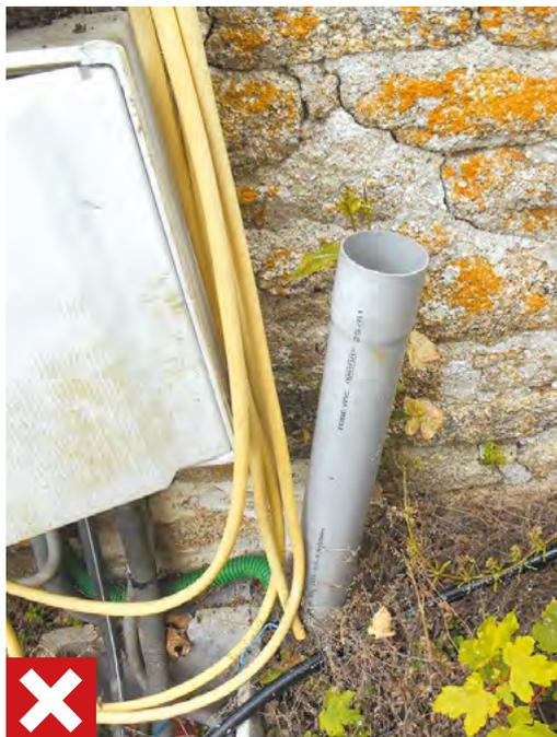
Evacuation inappropriée de l'air chargé en radon
