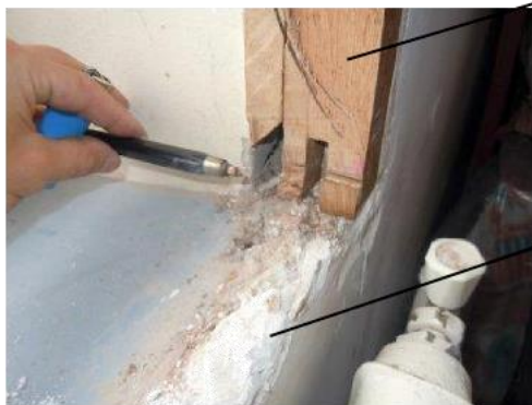
Figure 17 : Défaut d'étanchéité d'un dormant conservé en prévision d'une pose en rénovation de la nouvelle menuiserie
