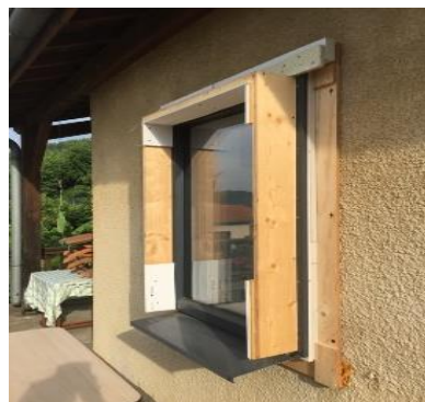
Figure 16 : Fenêtre posée en applique en attente d'une ITE
