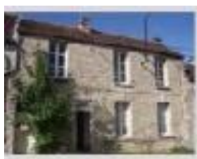
2-TH : isolation des combles perdus avant une ITI
