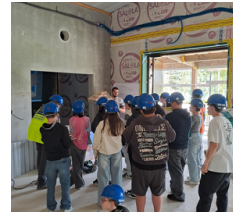
Les coulisses du bâtiment 9 octobre 2025 à Domagné (35)
