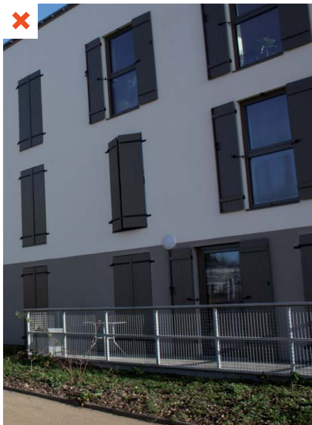
Volets extérieurs en bois utilisés comme protections solaires extérieures Façade Ouest. ©AQC
