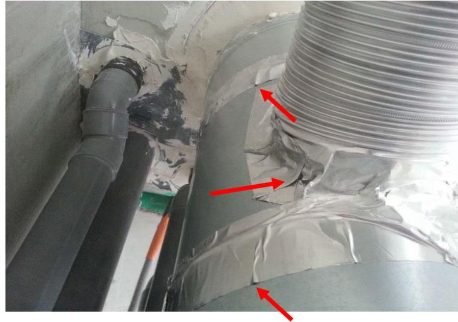
❖-> Prévoir un traitement au mastic lors de la jonction d'éléments découpés sur place.
