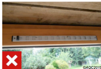
1. L'absence, la fermeture ou le mauvais dimensionnement des bouches d'entrée d'air frais peut-être responsable de l'accumulation de radon
