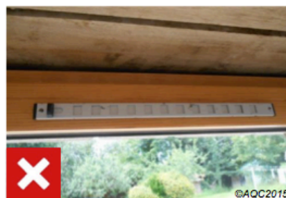
1. L'absence, la fermeture ou le mauvais dimensionnement des bouches d'entrée d'air frais peut-être responsable de l'accumulation de radon
