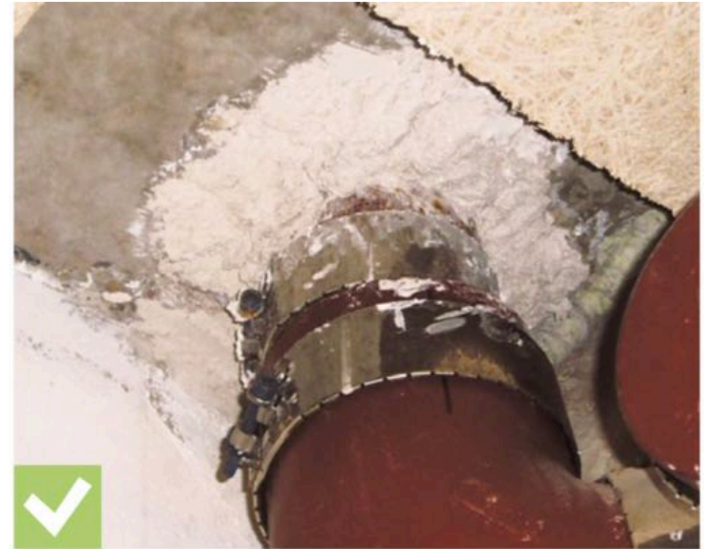
Obturation de défauts d'étanchéité ©CSTB
