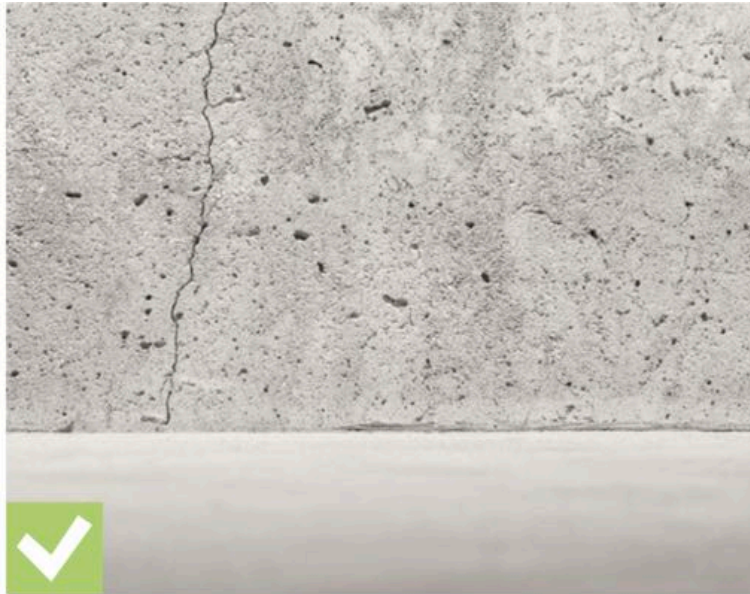
Pores et fissures par lesquelles le radon peut pénétrer dans le bâtiment ©CSTB
