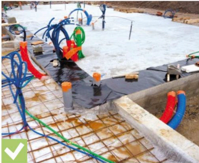
Pose de la membrane sous les murs ©Marvaud
