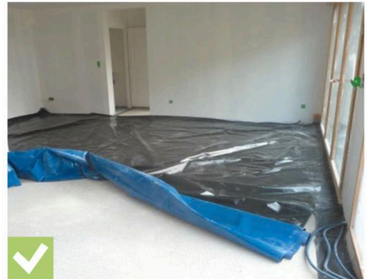
Pose du reste de la membrane une fois l'enveloppe terminée ©Marvaud
