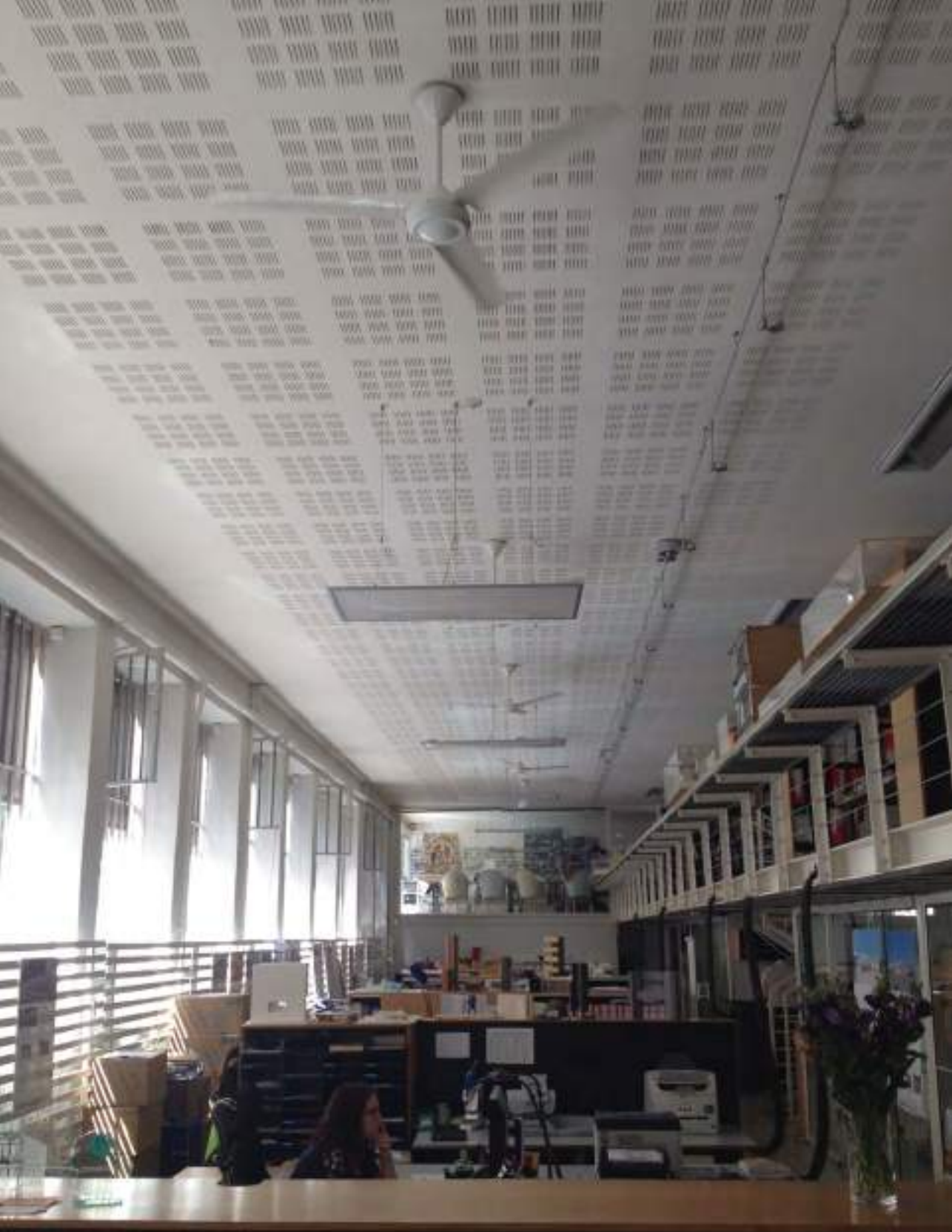
Bureaux sans climatisation, Gautier Conquet Architectes
