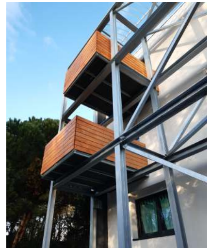
Structure déportée des balcons © RBBD
