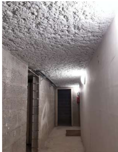
Isolation en sous face des caves © RBBD
