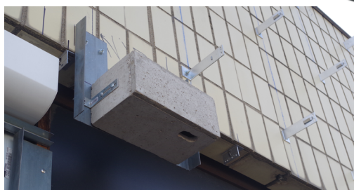
Intégration de niohirs à martinets noirs sur le site pilote APHP Saint-Antoine - Paris. © LPO IDF
