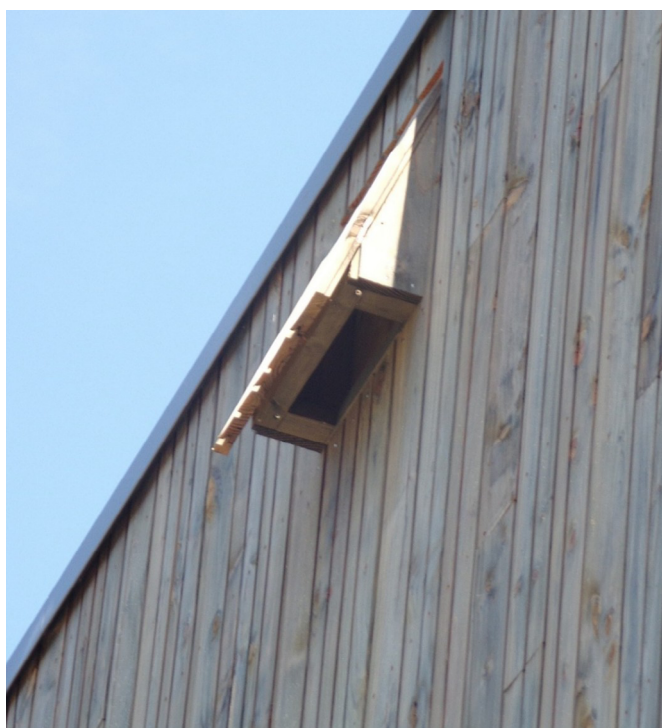
Aménagement d'un accès au vide d'air du bardage © Valentin Maugard
