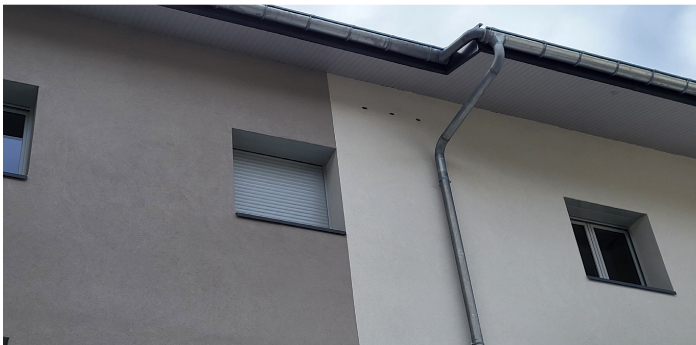
Nichour triple à martinets intégré dans l'isolant sur le site pilote de Grand Aigueblanche (73) © Ilan Badaoui
