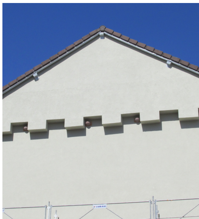
Aménagement de « créneaux à hirondelles » © LPO BFC
