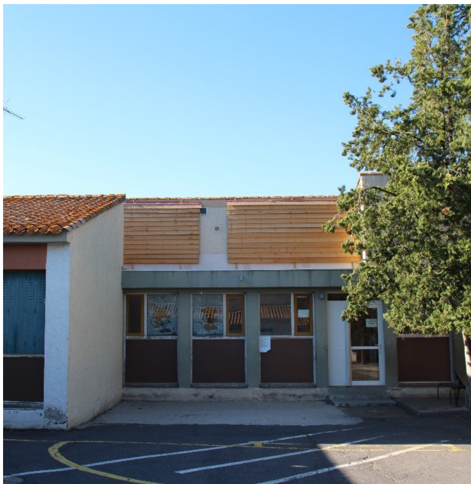
Pose d'un bardage sur une école pour créer des gîtes de repos/transit pour une colonie de Pipistrelles pygmées © Camille Montegu - LPO
