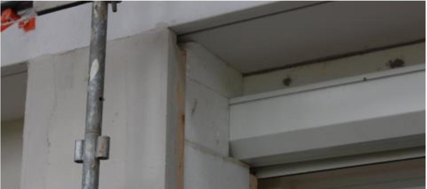
Mise en oeuvre de l'ITE amovible pour une menuiserie dont le volet roulant extérieur est fixé sur la maçonnerie © Réseau Breton Bâtiment Durable
