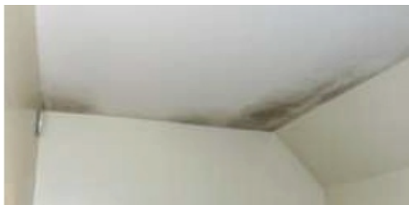
Identification des ponts thermiques en façade et dans les combles © API ingénierie
