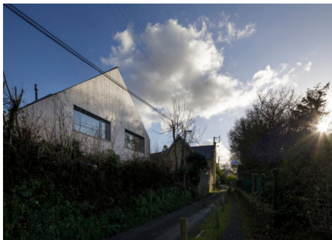
Figure 17 – Vue depuis la rue ©Batylab
