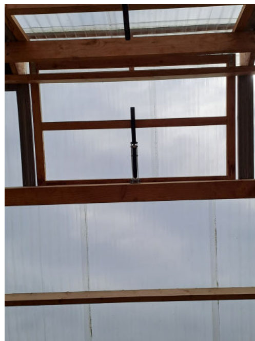
Figure 42 - photographie des trappes ©Batylab
