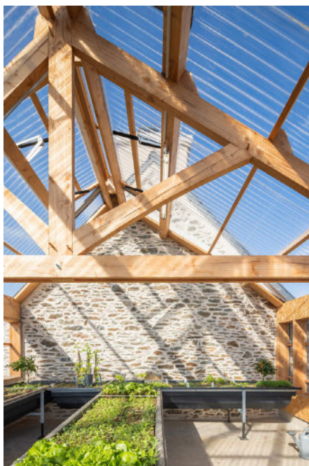
Figure 41 - photographie de la serre ©Batylab
