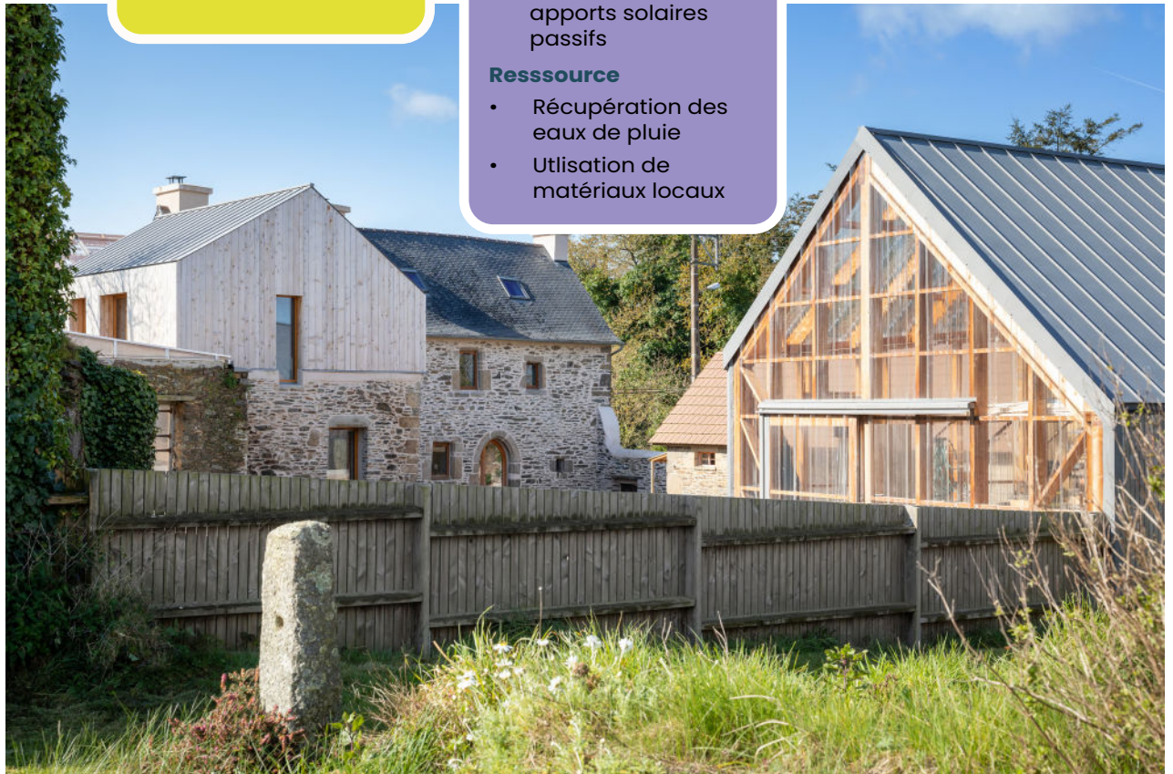
Figure 43 – photographie des trois phase de travaux (manoir en arrière plan, surélévation au centre et le cabinet à droite) ©Pascal LEOPOLD, photographe
