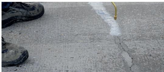
Béton autocicatrisant : application du système de réparation (liquide *Basilisk ER7*)
