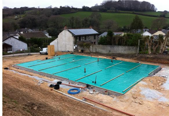
Pose d'une membrane anti-radon en construction neuve - © <http://www.properteco.co.uk>
