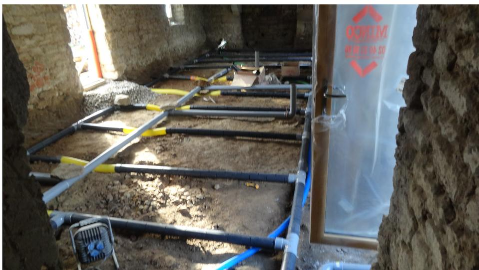
Installation d'un hérisson ventilé en rénovation. Photo : © Brélivet
