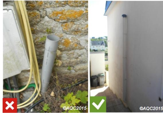
Evacuation inappropriée (photo de gauche) et correctement réalisée (photo de droite)
