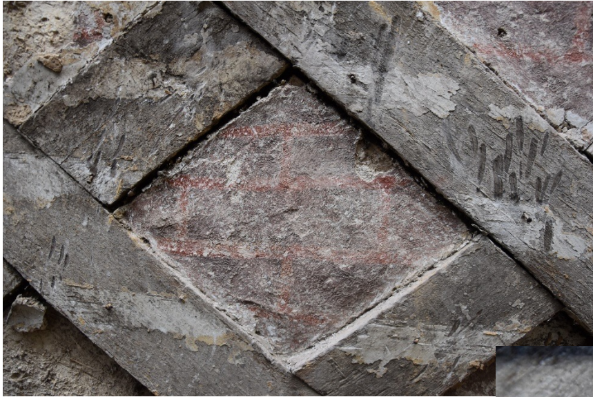
Immeuble pan de bois, Rennes (35)
