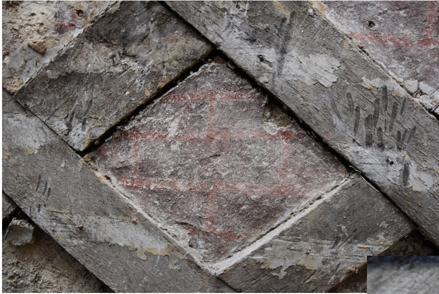
Immeuble pan de bois, Rennes (35)
