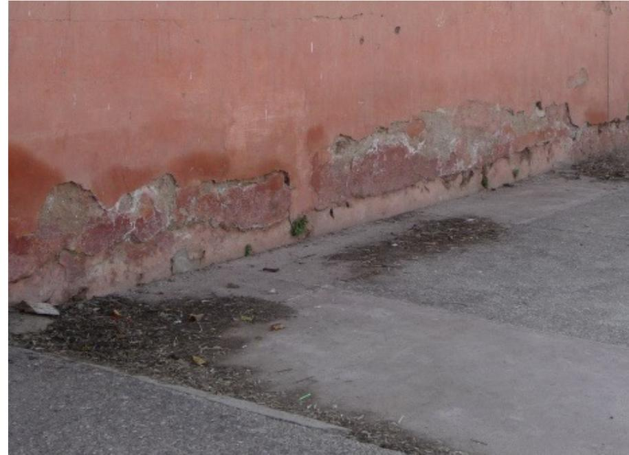
Dallage extérieur + carrelage intérieur + soubassement trop capillaire + enduit trop serré (faible porosité)
