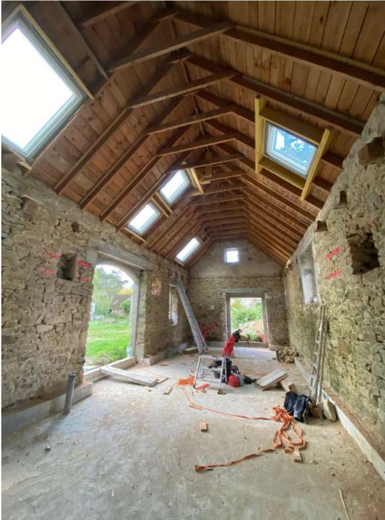
Limiter les ponts thermiques du plancher R+1
