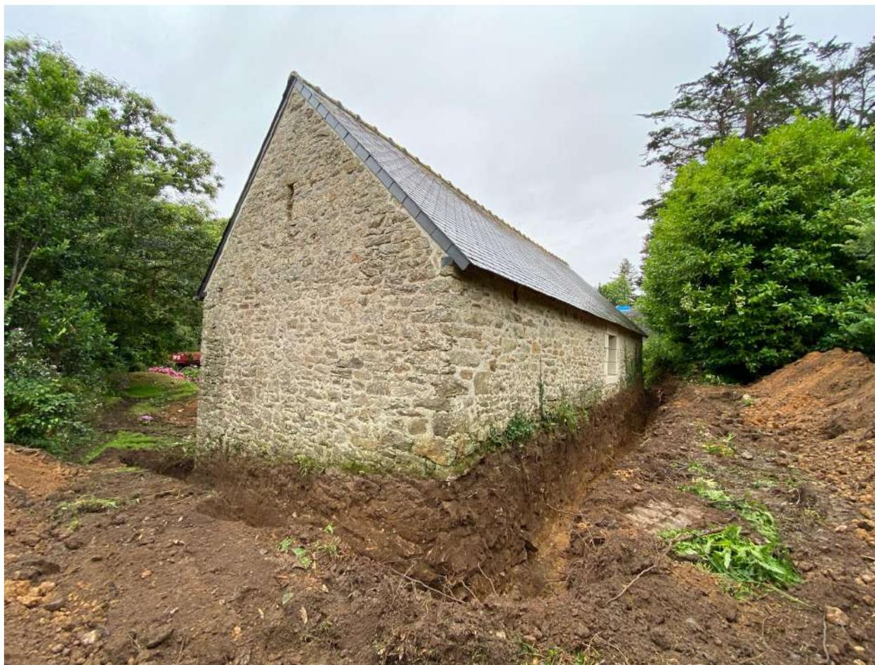
Limiter les remontées capillaires et renforcer l'étanchéité des murs :
