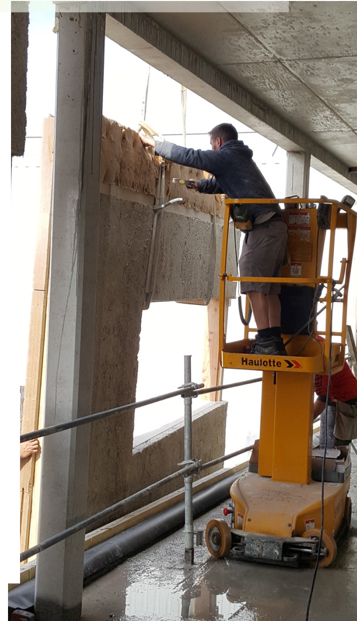
Pose des panneaux en chantier
